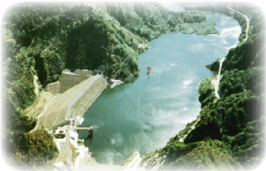
わが町の水がめ「白川ダム」
