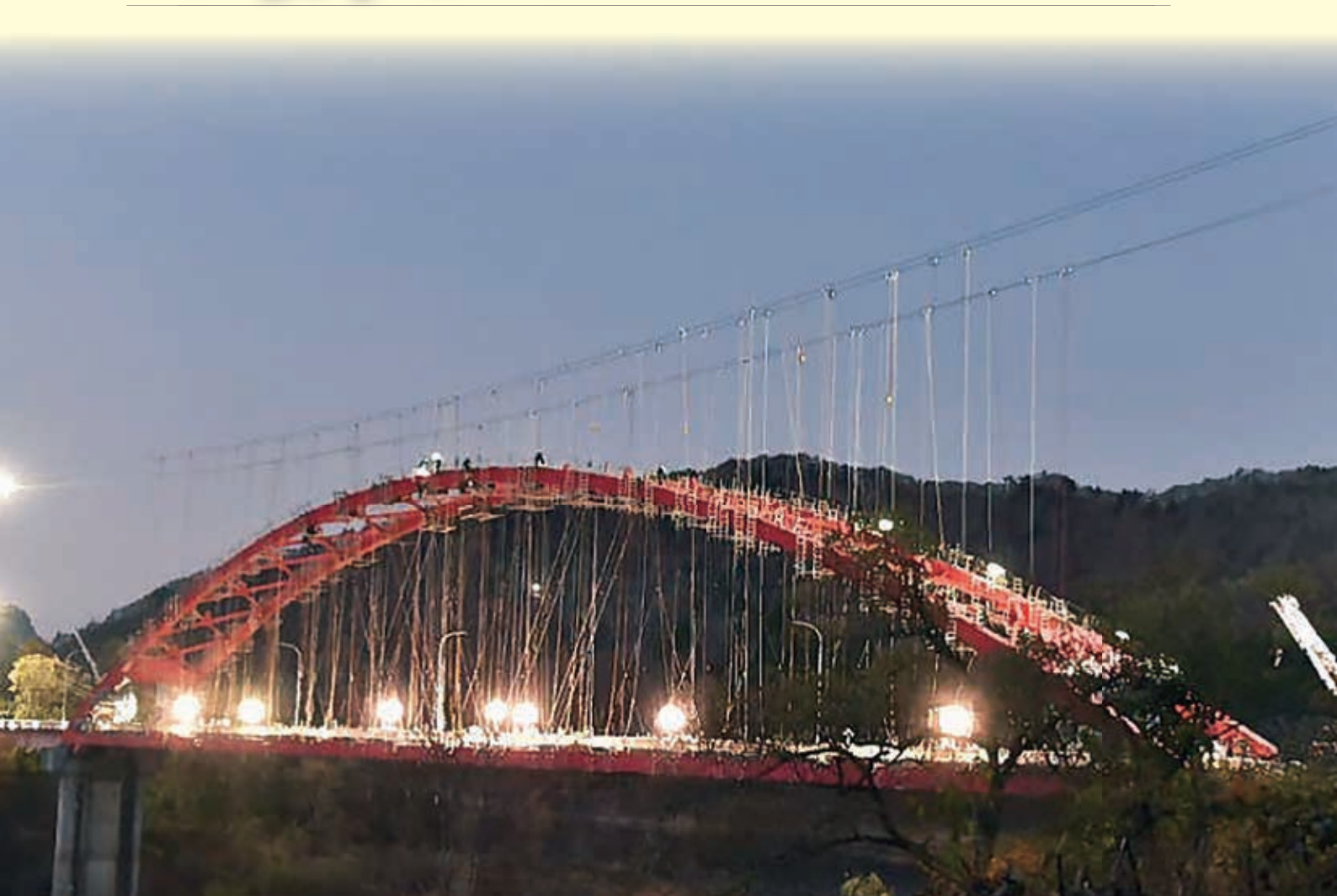
昼夜問わず復旧工事で降雪前に開通した中津川橋
