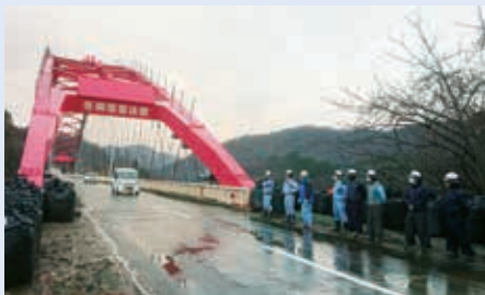
通過車輛を見送る工事スタッフ
