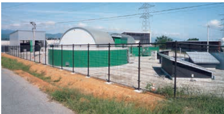
完成したバイオガスプロジェクト事業
