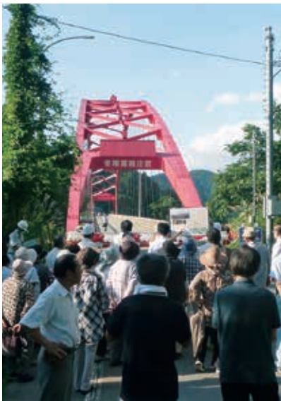
中津川橋の早期復旧を 地元住民の不安は大きい
