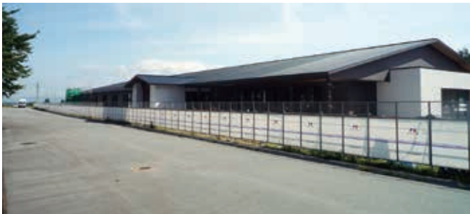
建設中の専門職大学
