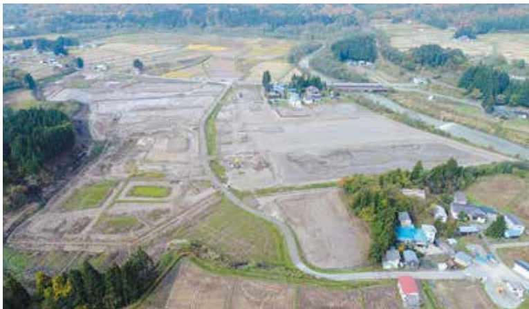
工事が進む手ノ子地区土地改良事業
