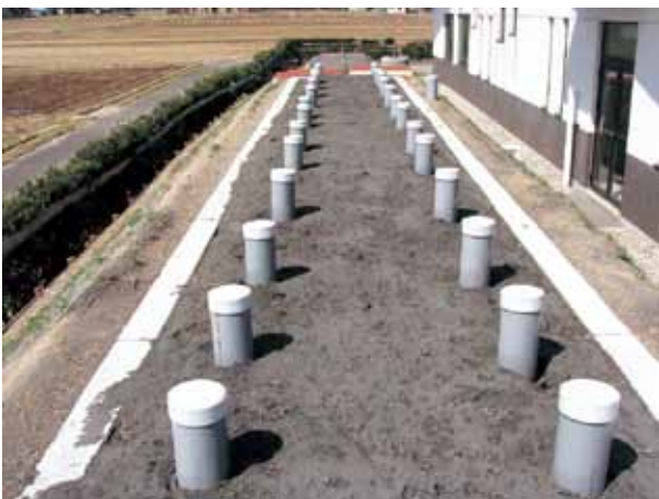
新汚泥処理システム (中地区)
