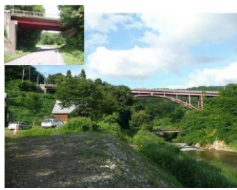
▲須郷橋(橋長 110.0m) アーチ橋
