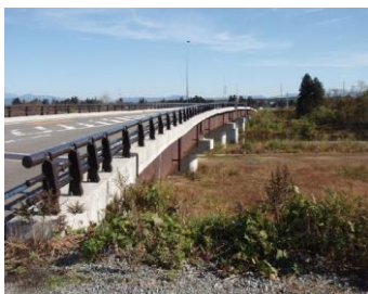
▲飯豊橋(橋長 213.5m) 耐候性鋼材
