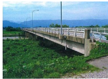
▲上白川橋(橋長 281.1m) PC 橋
