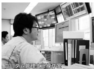
白川ダム管理支所操作室
