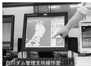
白川ダム管理支所操作室
