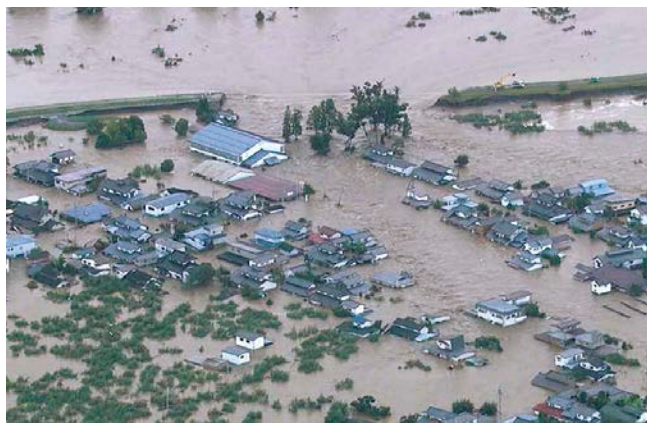
昨年の台風19号の被害では、記録的豪雨により各地に甚大な被害が発生
